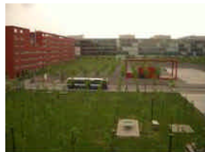
Wohnen, Arbeiten und Freizeit in Zürich Örlikon
